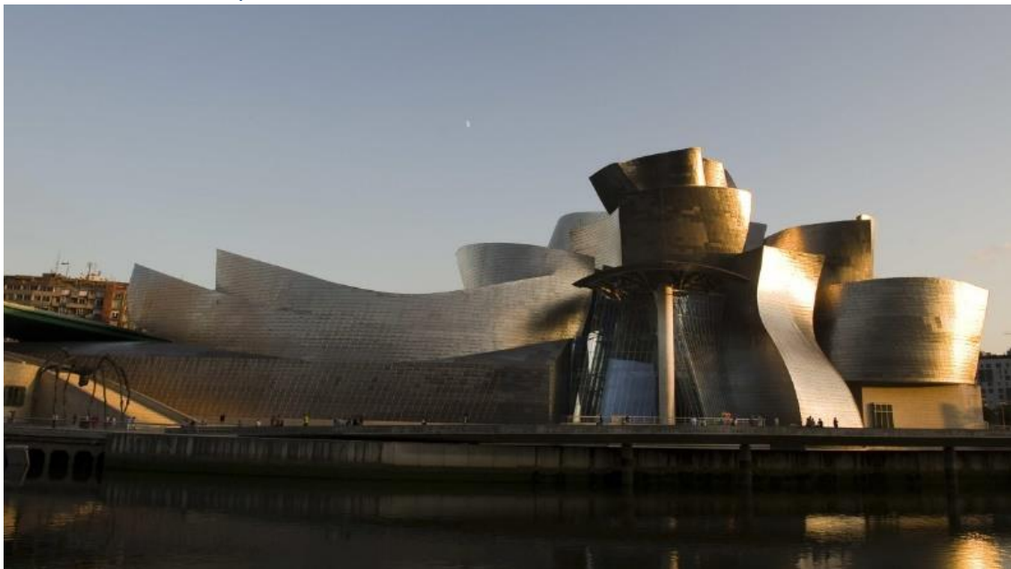
Frank Gehry, Guggenheim Museum Bilbao, Spanje, gebouwd tussen 1992 en 1997. Gehry maakte met de hand modellen voor dit complexe, organisch gevormde gebouw. Deze modellen werden vervolgens met gebruik van software voor het tekenen van 3D-modellen (CATIA), omgezet naar bouwtekeningen. De gevels van het gebouw bestaan uit titanium, kalksteen en glas.
