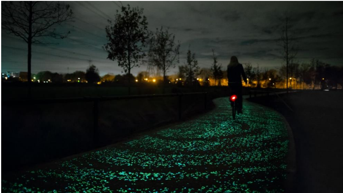
Afbeelding 10 Studio Roosegaarde, Van Gogh Path, 2012-2015, Nuenen-Eindhoven, onderdeel van het project Smart Highway. Het Van Goghpad is een fietspad met duizenden ingelegde zonlicht absorberende 'stenen' die in het donker oplichten. De oplichtende patronen doen denken aan de schilderijen van Van Gogh. Het resultaat is een visueel spektakel én een veiliger fietspad.
