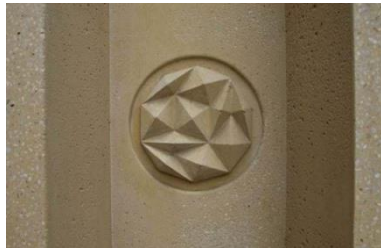
Afbeelding 38 Rozetvormige ornament van beton, in de gevel van cultureel centrum Rozet in Arnhem (2013)
